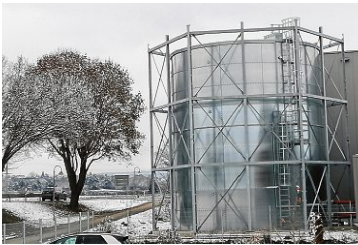
Der Sprinkler-tank wird mit Solarzellen verkleidet.
